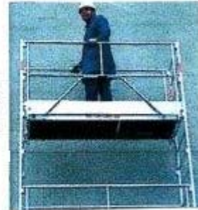
Mise en place des garde-corps
