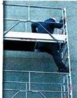
Accès à l'étage supérieur sécurisé
