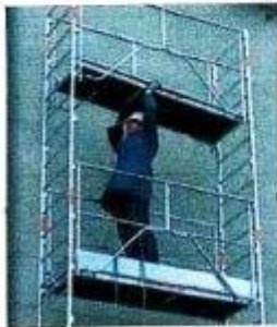
Mise en place du plancher
