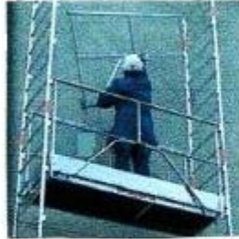
Mise en place des garde-corps
