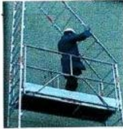
Mise en place des échelles
