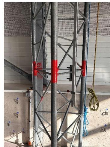
**Dispositifs d'ancrage et ancre structurelle non garantis nécessitant un principe de redondance pour les travaux d'accès et de positionnement aux moyens de cordes. Marquage bleu**
