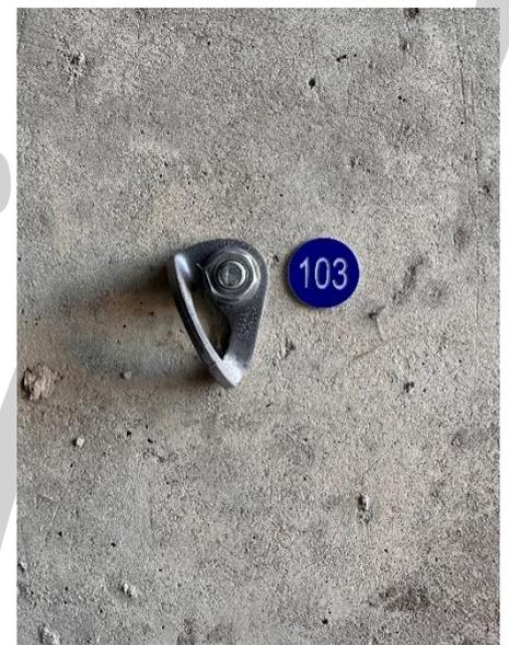
**Les tests de validation des dispositifs d'ancrage et des ancrs structurelles sont réalisés selon la recommandation de la CNAMTS R430 pour une utilisation antichute.**
